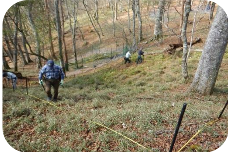
ネットを張る位置を決めて、支柱を打ちます
