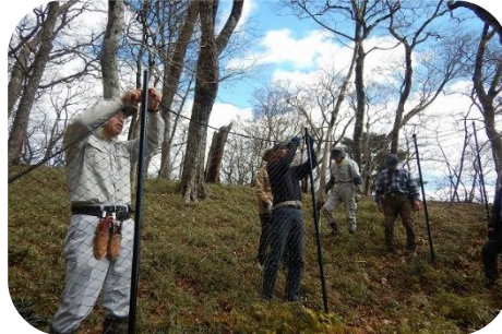
支柱にネットをとめていきます
